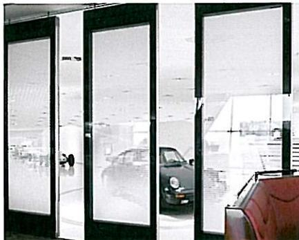
**Im Einsatz:** ESG-Weissglas-Elemente, nach Architekturvorgabe beidseitig mit Linienraster im Siebdruck bedruckt. Unsichtbar befestigt und einzeln austauschbar.
