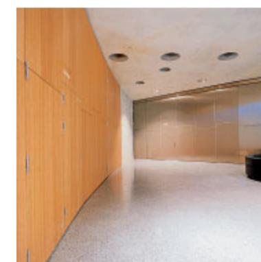
Generell unterscheiden sich unsere beiden Elementschiebewände E8 und E10 durch ihre Wandstärke und ihre Schalldämmung. Bei 84 mm Stärke (E8) können die Wände bis zu 45 Dezibel schalldicht sein. Ab 46 Dezibel beträgt die Wandstärke 100 mm.
